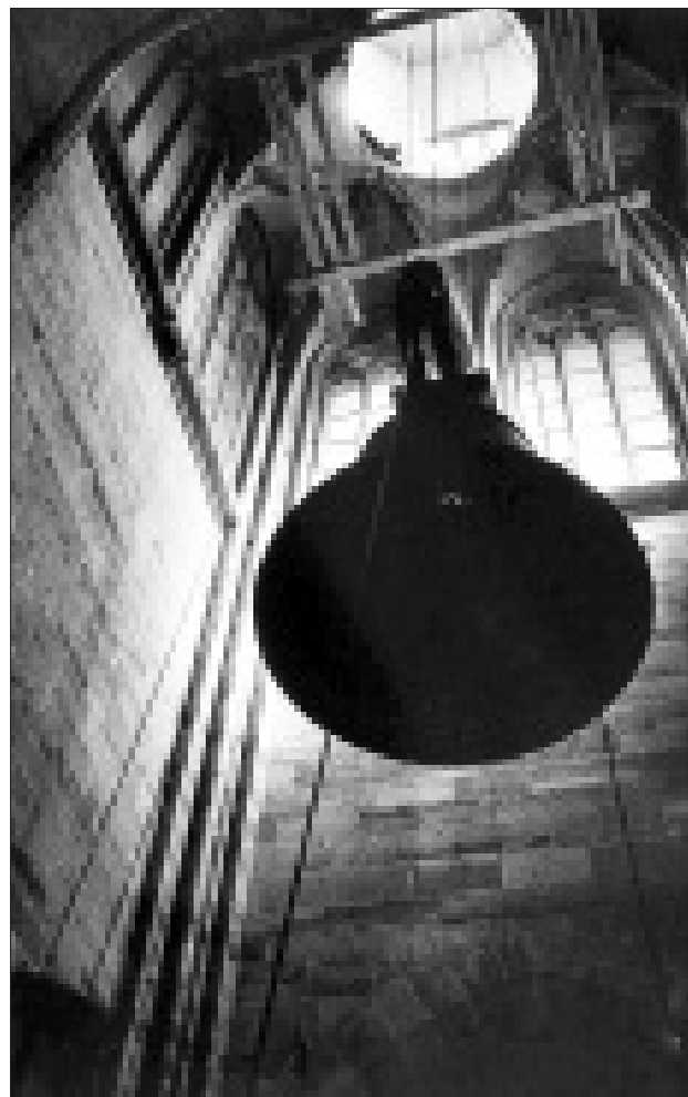
Aufziehen der Pummerin auf den Nordturm
